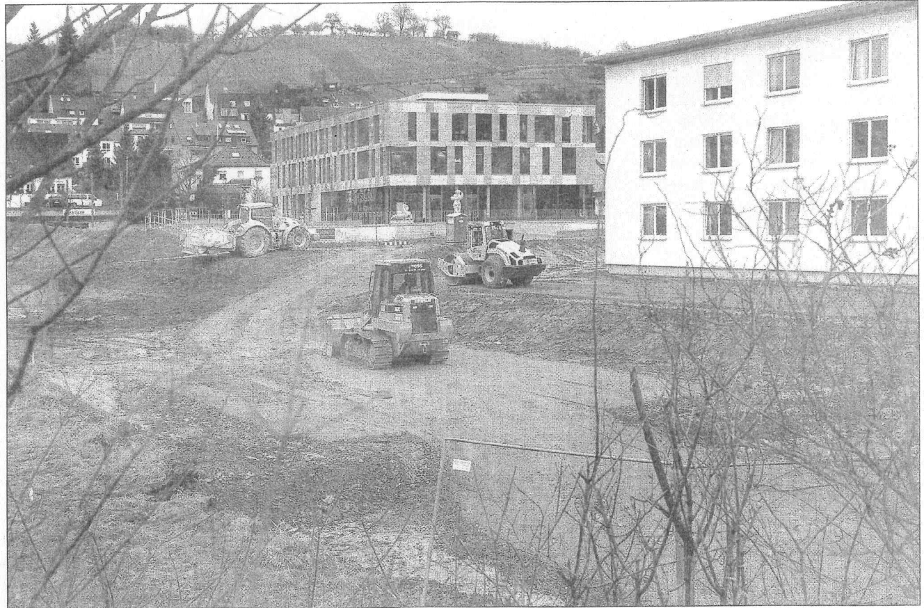
Projekt Pflegeheimerweiterung: Die Baugrube (rechts) für den Neubau ist ausgehoben.
