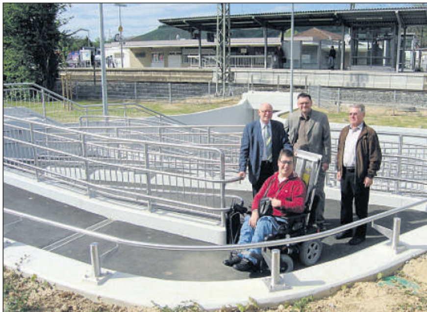
Endlich barrierefrei: 2011 ist der Grunbacher S-Bahnhof umgerüstet worden. Eine 63 Meter lange Rampe führt zu den Bahnsteigen. Der Grunbacher Simon Maier ist froh über den Umbau. Ebenso sein Vater Walter Maier (rechts) sowie Landrat Johannes Fuchs und Bürgermeister Norbert Zeidler. Bild: Privat
