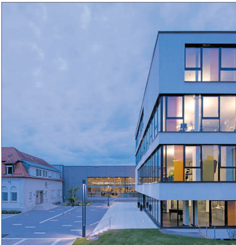
Gläserne Produktion bei Klingele: Links das 1936 errichtete Stammwerk von Klingele, rechts das neue Verwaltungsgebäude, das beim Wettbewerb „Beispielhaftes Bauen im Rems-Murr-Kreis“ zusammen mit dem neuen, ebenfalls vorgelagerten Werk ausgezeichnet wurde. Bilder: Klingele
